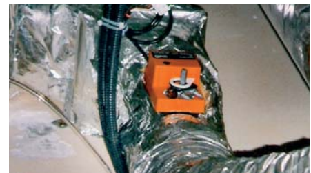
NM24-MFT2 mit Sensor am MP-Bus.
