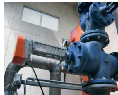
Regelventil mit Antrieb AV24-MFT2 am MP-Bus.
