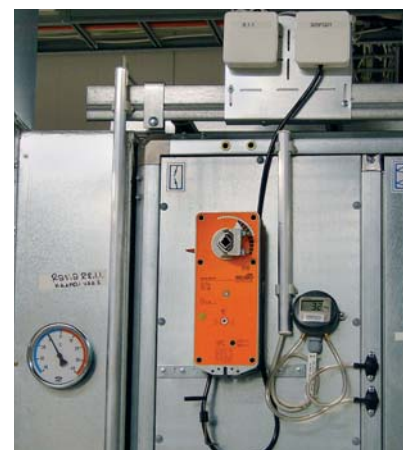
AF24-MFT2 mit \Delta P -Sensor, integriert via MP-Bus.
