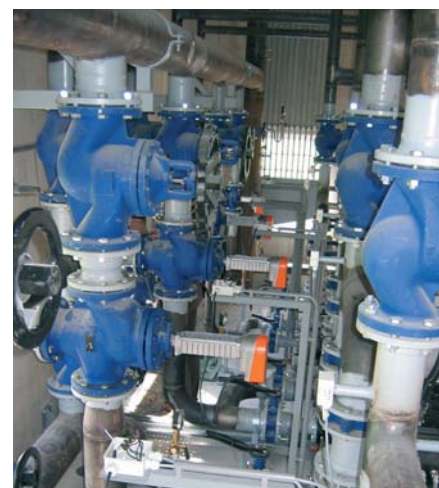
Alle Regelventile sind über den MP-Bus zusammengefasst.
