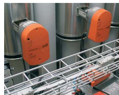
Klappenantriebe, Volumenstromregler, Ventiltriebe und Sensoren am gemeinsamen MP-Flachbandkabel-Strang.
