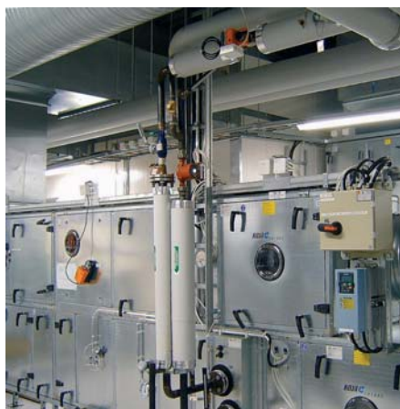
Luftaufbereitungscentralgerät, komplett mit MP-Bus-Technologie ausgerüstet.
