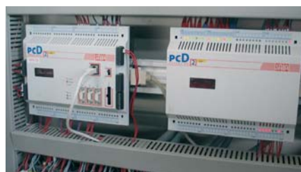
Speicherprogrammierbare Steuerung SPS der Reihe PCD2 mit MP-Schnittstelle von SAIA-Burgess Controls.
