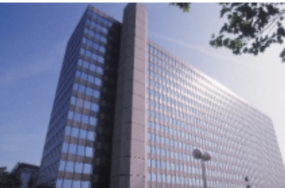
La tour ZDF des rédactions et de l'administration: 850 bureaux sont équipés de vannes à boisseau sphérique de régulation Belimo
