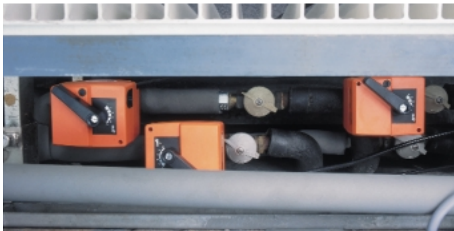
Compacts, robustes et fiables: les nouvelles vannes à boisseau sphérique de régulation motorisées de Belimo remplacent les vannes à siège pneumatiques classiques
